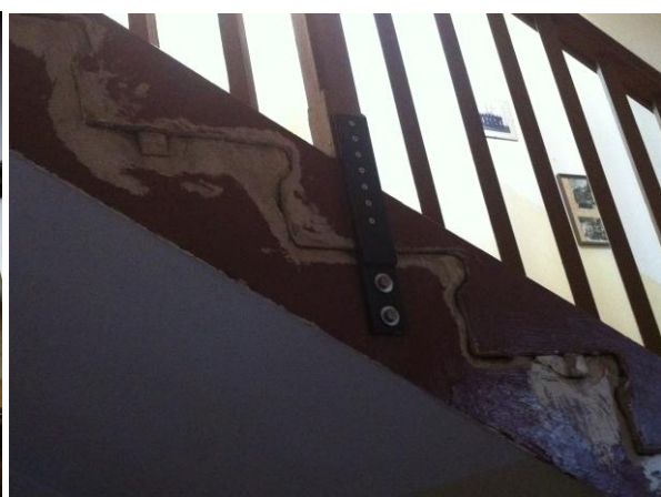
rechts: Treppenhaus der FF Adlershof
